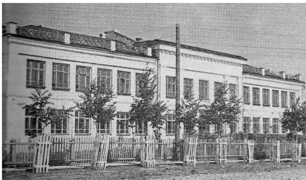
Фабрично-заводская семилетняя школа, где 23 марта 1932 года в двух её кабинетах приступили к занятиям учащиеся Исовского вечернего дражно-гидравлического горного техникума. Всё оборудование техникума помещалось в одном шкафу.
